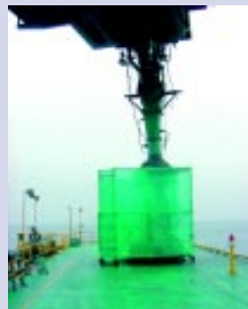
Andamio cobertor que cubre la cuchara del shiploader en el muelle de Puerto Punta Lobitos y que protege del viento de la zona.
